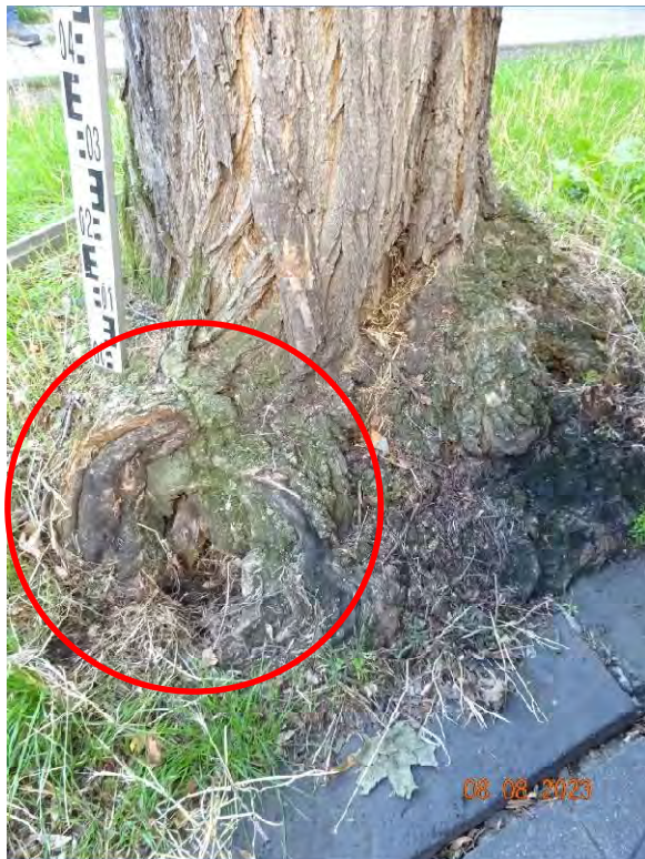
Abb. 7: Baum-Nr.2: Faulstelle an Wurzelanlauf
